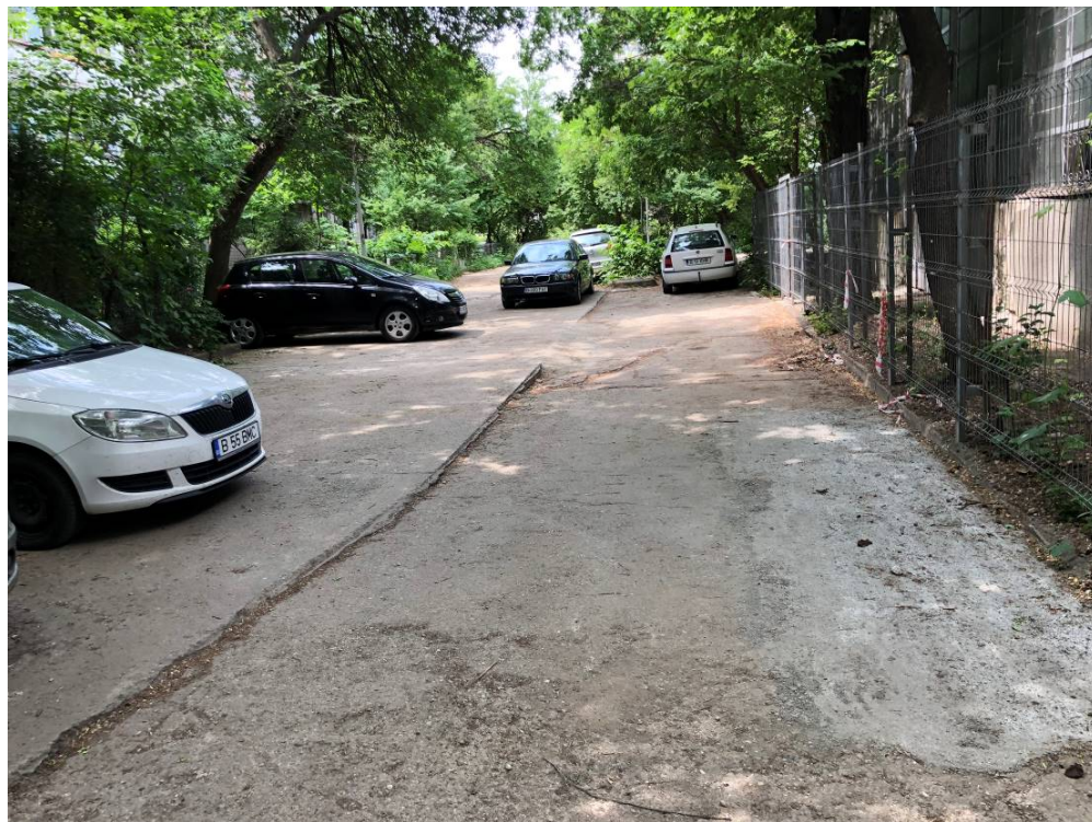
Foto Axa 23 – Din Axa 22, adiacent Bl. 26 si centrala termica
