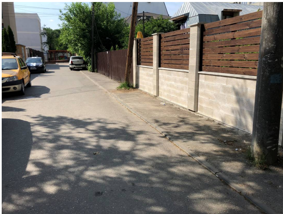
Foto Axa 12 – adjacent str. Floare Rosie nr. 7, BI 51 si camin de batrani nr. 6
