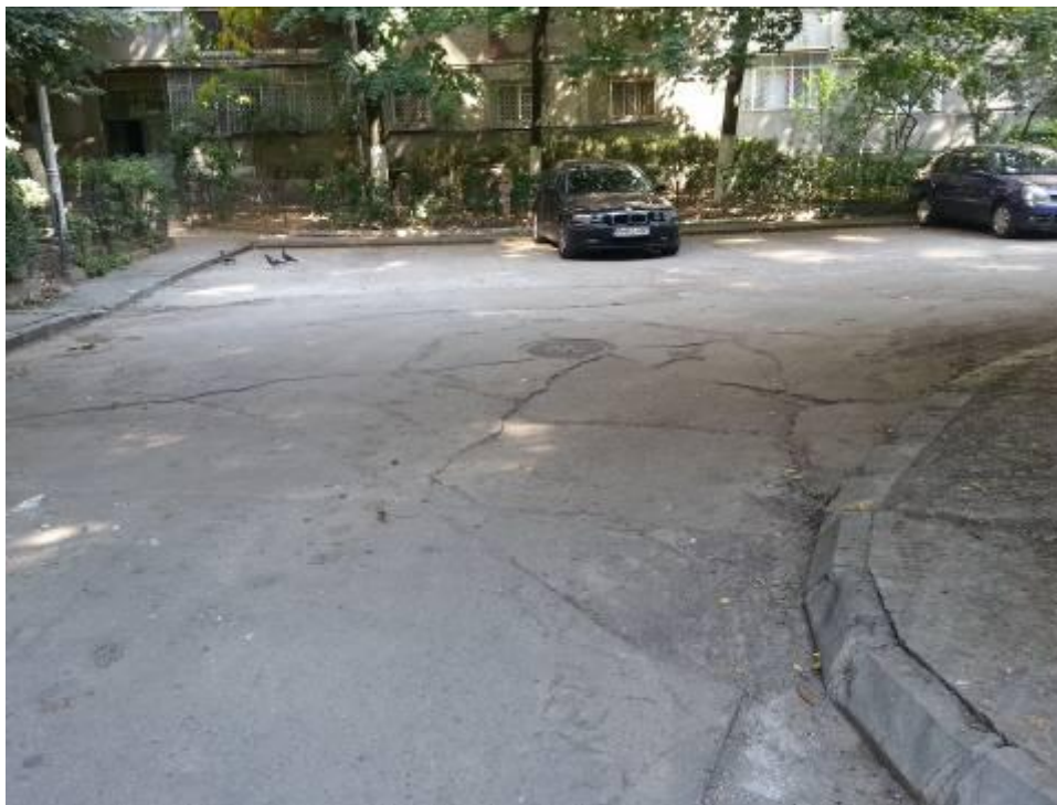
Figura 8 - Strada Simion Mehedinți - tronsonul delimitat de blocurile 115, 114, 113, 117, 116 și 115a
