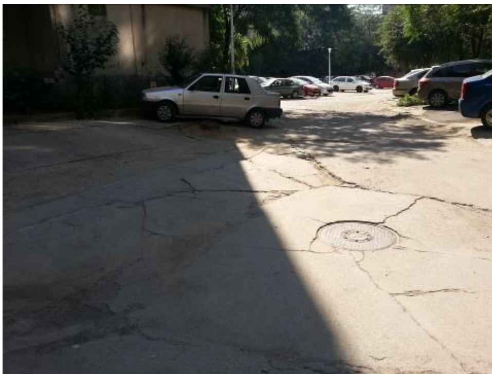
Figura 9 - Strada Simion Mehedinți - tronsonul delimitat de blocurile 115, 114, 113, 117, 116 și 115a
