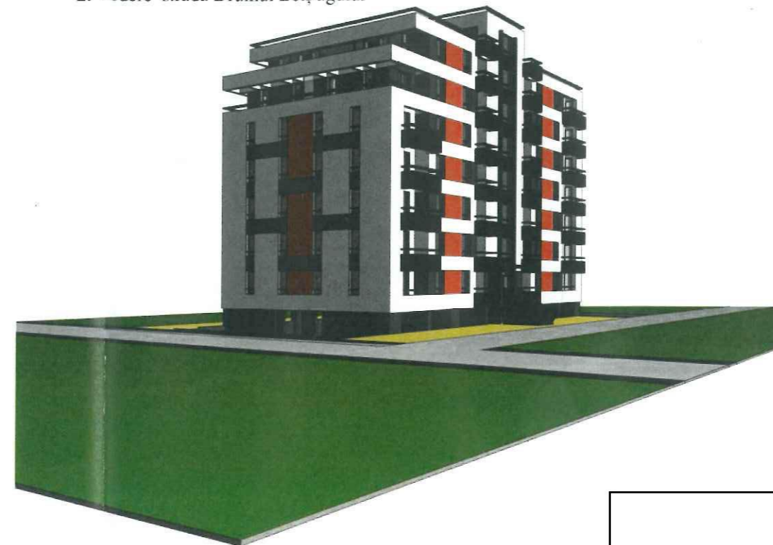
2. Vedere strada Drumul Belșugului
