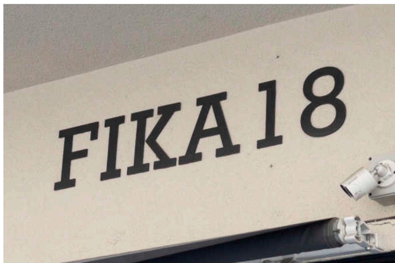
✓ Litere aplicate pe fațadă.
