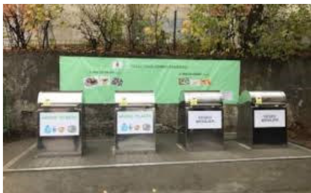
Exemplu punct de precolectare a deșeurilor subteran
