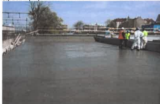
Aplicarea membranei bituminoase:
