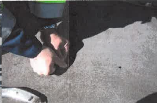
Controlul aderenței membranei bituminoase:
