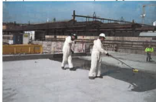
Suprafata dupa aplicarea celui de al doilea strat de amorsa MMA:
