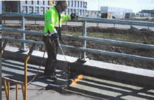
Controlul aderenței membranei bituminoase:
