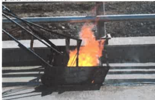
Aplicarea membranei bituminoase:
