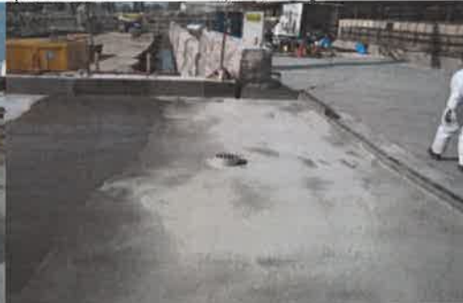
Aplicarea membranei bituminoase pe suprafata amorsata:
