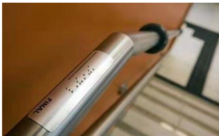
Figură 2 - Marcaj propus pentru maini curente, adaptate persoanelor cu deficiente de vedere
