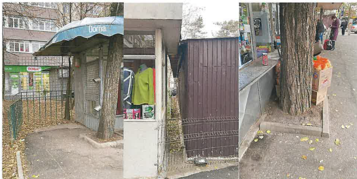
Figură 4 - Exemple de deficiente
