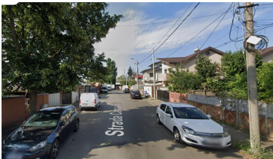
Figura 2. Vedere situație existentă în zona terenului studiat – poza iulie 2023
