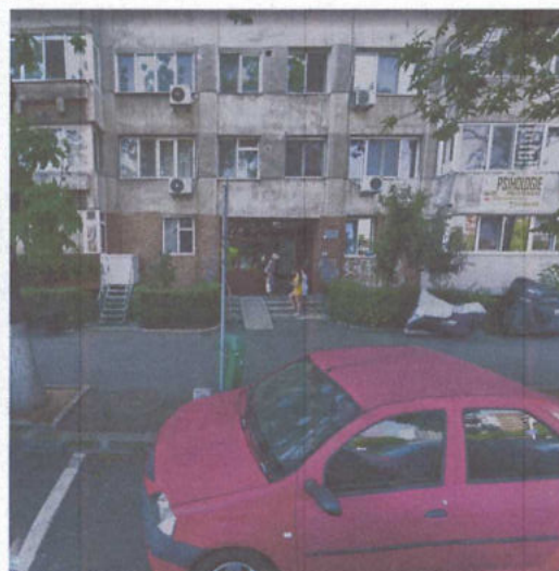
Intrare în scara de bloc neadecvată pentru persoanele cu dizabilități
