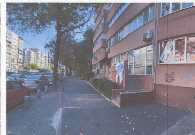
Fiecare proprietar a folosit o soluție diferită pentru a rezolva diferența de nivel dintre cota trotuarului și cota interioară de călcare
